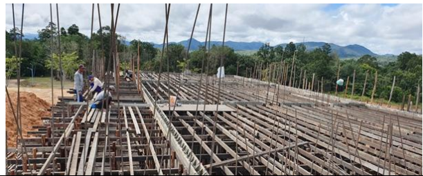
Vorbereidingen voor een betonplaat voor de tweede verdieping van het nieuwe schoolgebouw met 12 klaslokalen.
